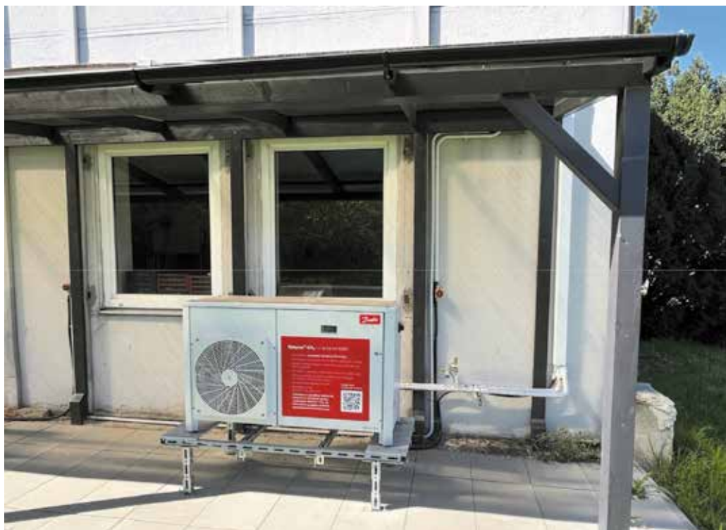
Obr. 2: Pro účely školení máme k dispozici funkční jednotku Danfoss Optima na chladivo R744
