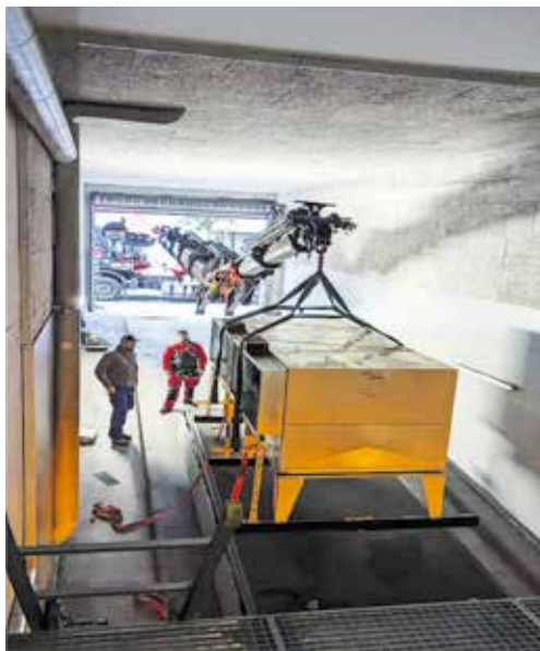
Plynový chladič byl instalován téměř vodorovně pomocí nakládacího jeřábu
