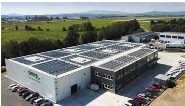
Obr. 6: Letecký pohled na moderní výrobní halu Sinop BT. Na střeše jsou vidět FV panely a v pravém dolním rohu dva kontejnery, ve kterých je umístěna technologie tepelného čerpadla.
