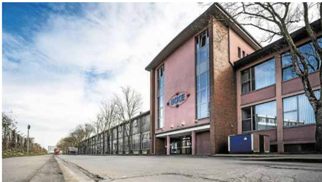
Obr. 1: Škola chlazení I-K-K-E stojí na místě jedné z budov bývalé ocelárny Krupp v Duisburgu
