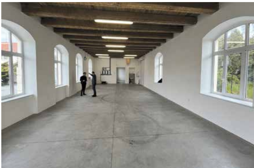
Obr.3: Takto vypadá prázdný prostor budoucí praktické učebny/dílny chlazení. Prostory jsou nově zrekonstruované s velkými okny a v betonové podlaze je zabudováno podlahové vytápění. V patře nad dílnou je k dispozici kuchyňka a dvě učebny teoretické výuky.
