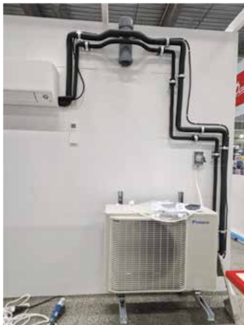
Obr. 3: Pohled na Honzovu práci první části soutěže – instalaci splitové klimatizace. Hodnotilo se dokončení prací ve stanoveném čase, dodržení rozměrů podle projektu, funkčnost systému, provedení ohybů a spojů potrubí, kvalita provedení izolace a samozřejmě dodržování bezpečnosti práce.
