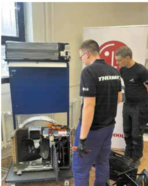
Obr. 6: Diagnostika závad probíhala pod dohledem zkušební komisaře Patrika Procházky (vpravo)
