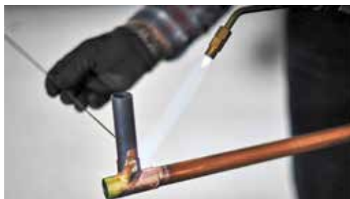
Obr. 5: Důležité je rovnoměrné rozlití pájky v celé ploše styku
