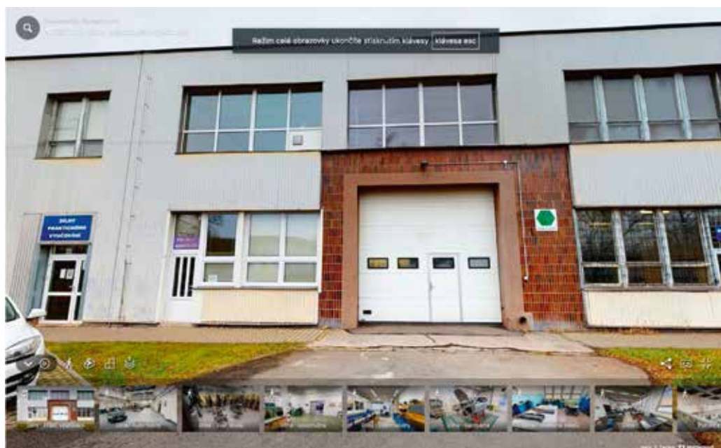
Obr. 1: Budova dílen, ve které je i nová učebna pro kurzy chlazení
