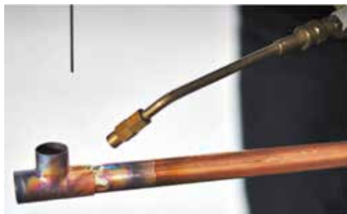
Obr. 4: Spojení fitinky s trubicou stříbrnou pájkou
